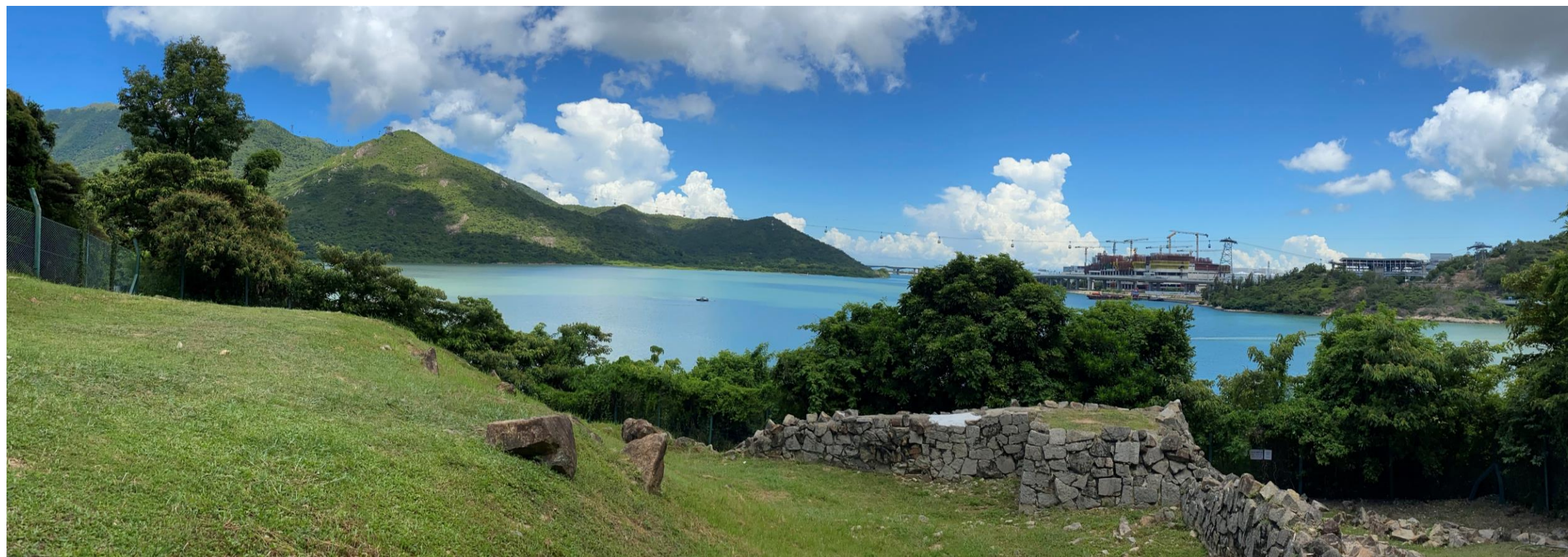
VSR 9 Tung Chung Battery
